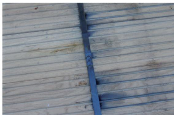
1 Reaktionsverfärbung auf Eiche durch Eisen-Stahlband
