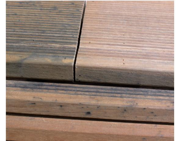
5 Flächige Verfärbung durch Eisenstaub auf den Brettoberflächen und durch Eisenspäne an den Brettenschmalen – Brettstück rechts oben mit Oxalsäure behandelt
